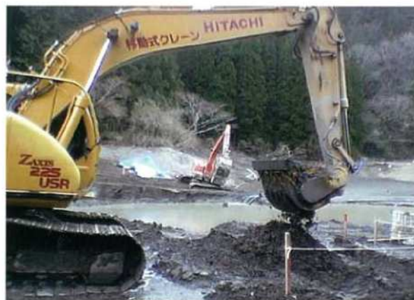
攪拌改良状況
